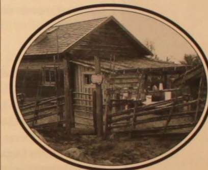
Ett av alla husen på Ärteråsens fåbod. Foto: Fredrik Holm
